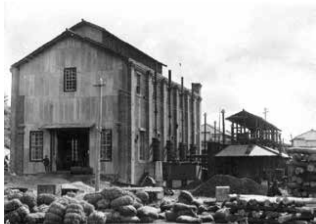
(写真 46) 火力発電所建屋 (大正2年(1913)8月撮影)
