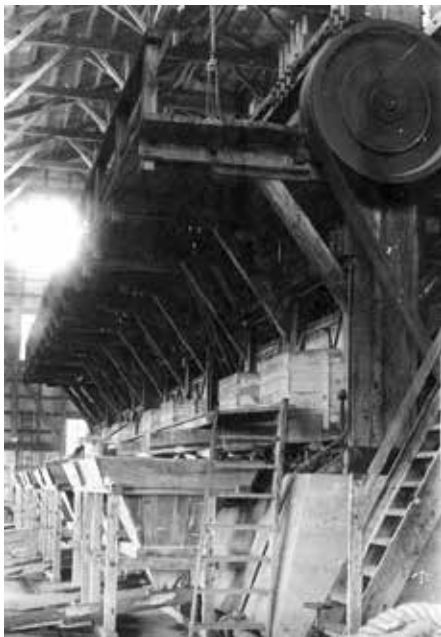
(写真 50) カリフォルニア式搗鉦機の試運転 (大正 2 年 (1913))
