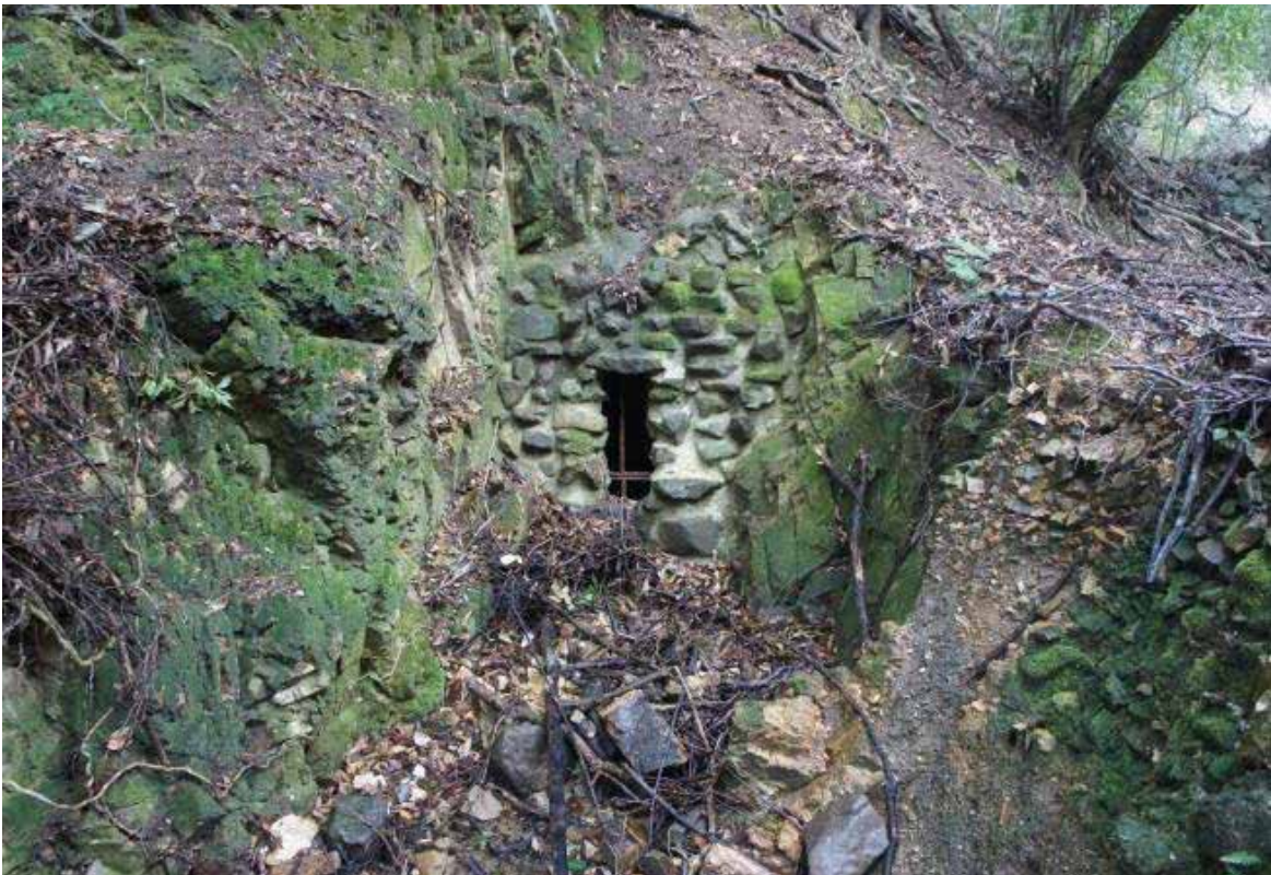
(写真 32) 野首坑口
