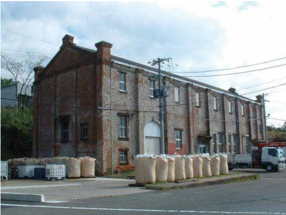
(写真 40) 大正 2 年に建設された発電所建屋
