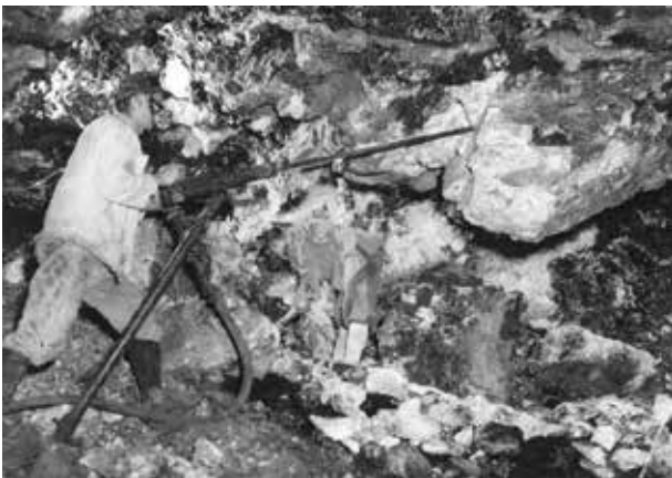
(写真 72) 串木野鉱山一坑坑内穿孔作業 (昭和 25 年(1950)11 月 11 日)
