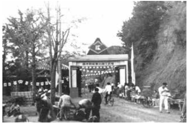
(写真 71) 神岡鉱業(株)串木野鉱業所竣工式 (昭和 25 年(1950)5 月撮影)
