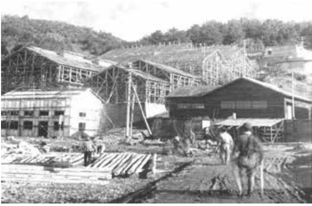
(写真 70) 串木野製錬所再建工事 (昭和 25 年(1950)1 月 27 日撮影)
