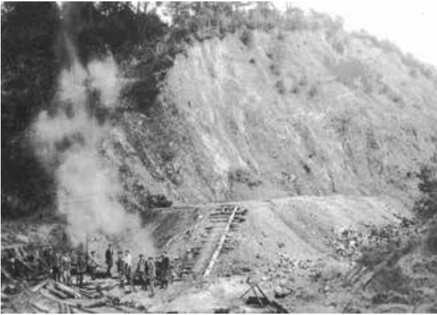
(写真 75) 新二坑斜坑口 (昭和 25 年(1950)撮影)
