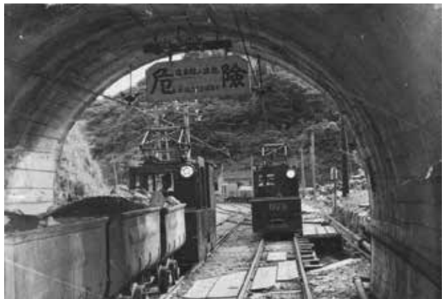
(写真 73) 串木野鉱山一坑通洞坑口出口 (昭和 25 年(1950)11 月 12 日撮影)
