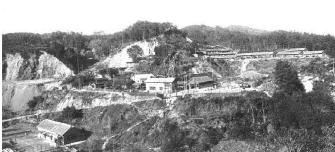
(写真 56) 一坑大壑坑周辺全景 (昭和 3 年 (1928) 6 月 8 日)
