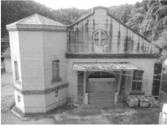
(写真 92) 島津家大田発電所 (平成 27 年(2015)9 月 22 日撮影)
