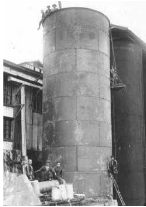
(写真 60) 増設工事中的のパチェカタンク (昭和 8 年(1933)2 月 8 日 撮影)
