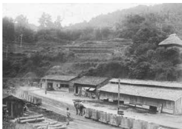
(写真 55) 一坑通洞前馬匹牽引鉦車 (昭和 3 年 (1928) 6 月 8 日 撮影)
