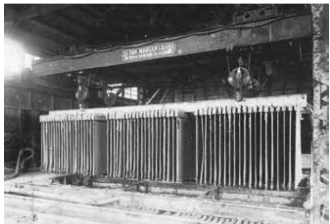
(写真 48) ムーア濾過機試運転 (大正2年(1913)10月撮影)
