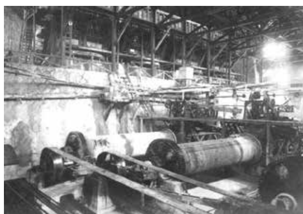
(写真 58) ペブルチューブミル (昭和 3 年 (1928) 撮影)
