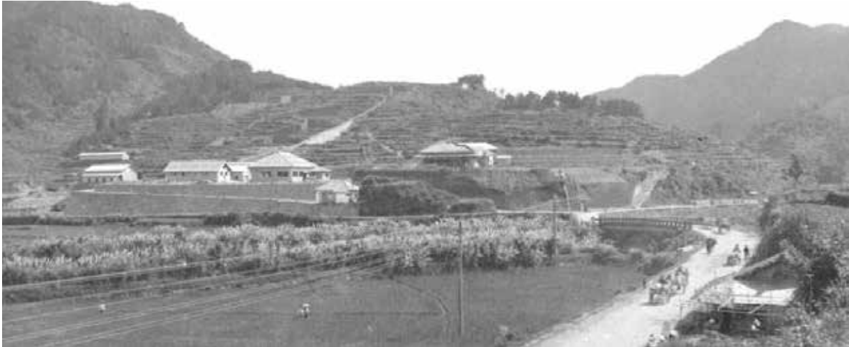
(写真 44) 本格建設工事前の串木野製錬所 (大正元年(1912)9月撮影)
