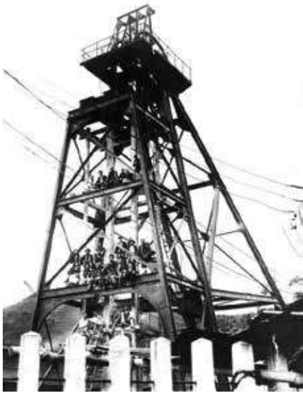
(写真 66) 串木野鉱山大堅坑櫓 (昭和 13 年(1938)10 月撮影)
