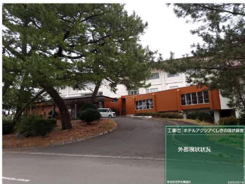
北面 現状状況
