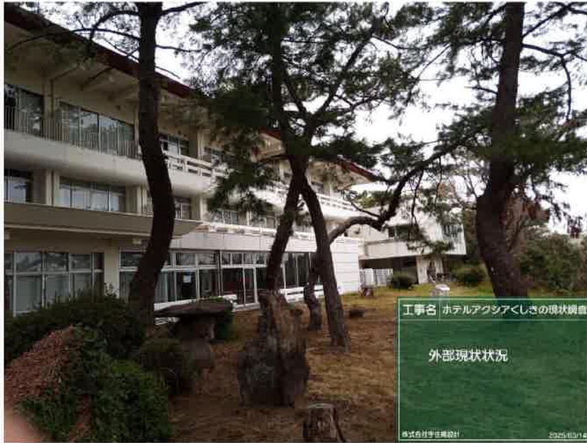
南面 現状状況
