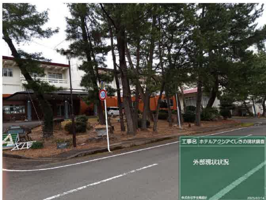
北面 現状状況
