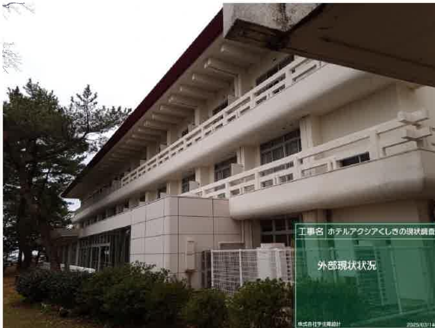
南面 現状状況
