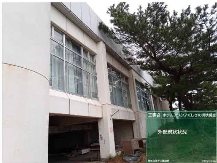
西面 現状状況
