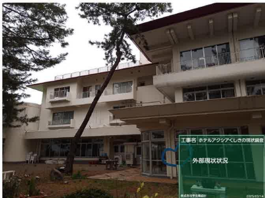
南面 現状状況
