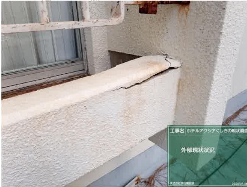
コンクリート手すり状況
