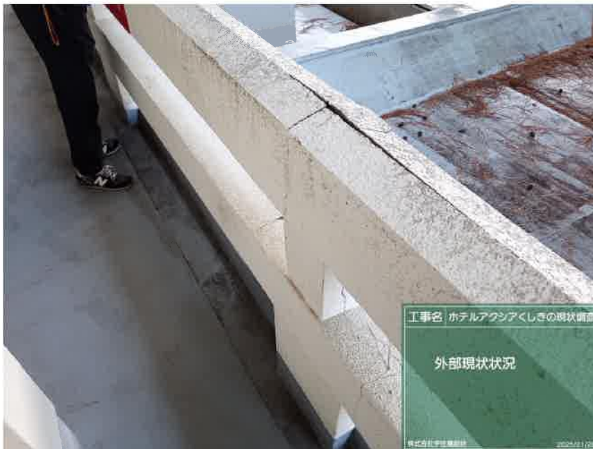
コンクリート手すり状況
