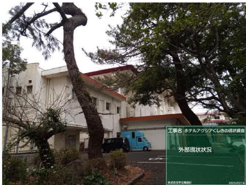
北面 現状状況
