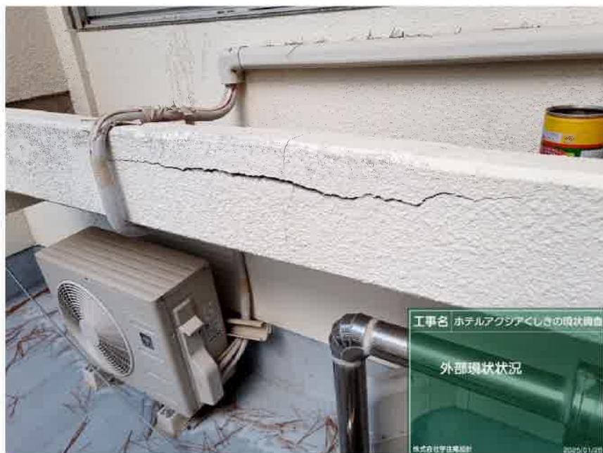
コンクリート手すり状況
