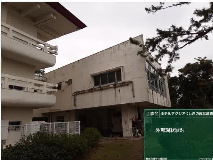
南面 現状状況
