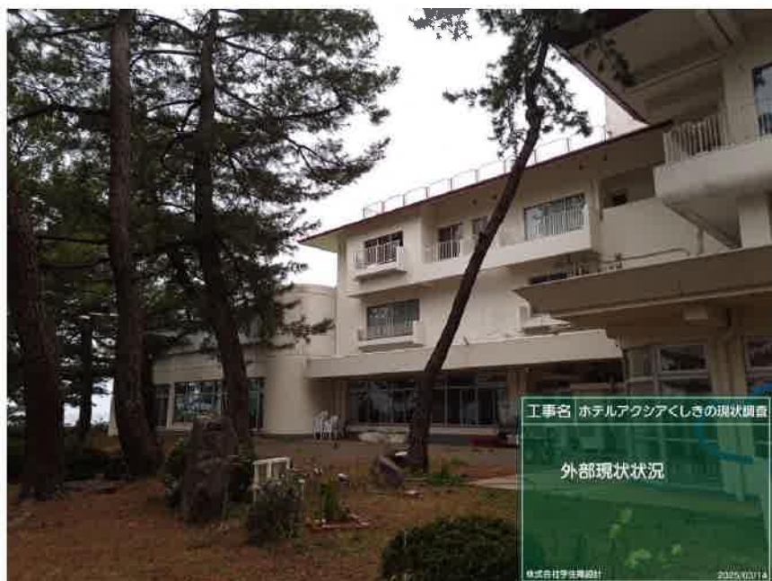
南面 現状状況
