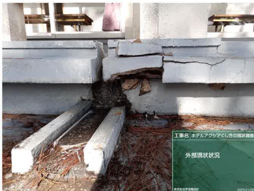
コンクリート手すり状況
