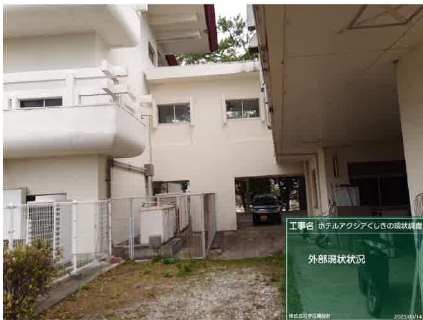
南面 現状状況
