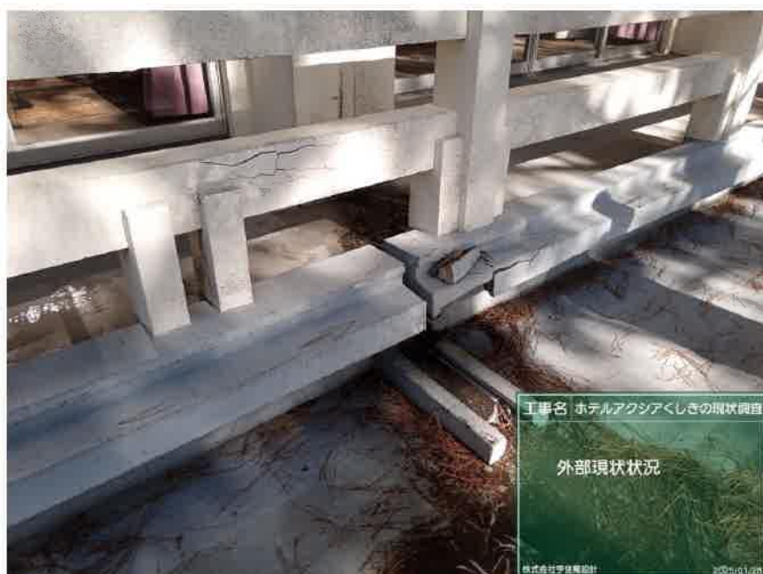
コンクリート手すり状況
