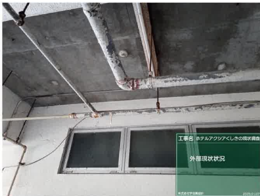
地階 ピロティ
