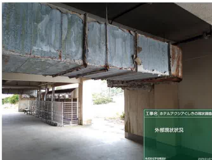
地階 ピロティ
