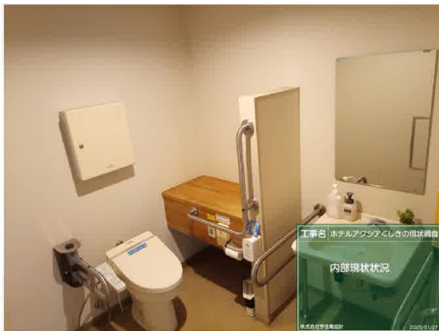
1階 ロビーWC
