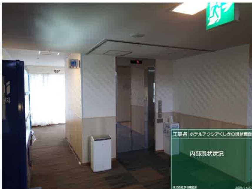
3階 エレベーターホール
