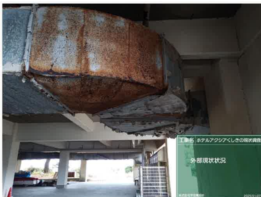
地階 ピロティ
