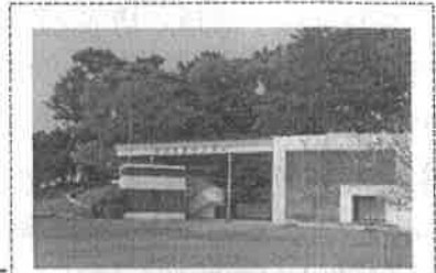
解体予定の海浜児童センター
