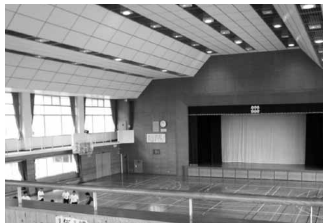
串木野中学校屋内運動場つり天井
