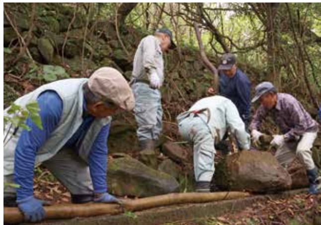
開水路に溜まった枝葉等を撤去
