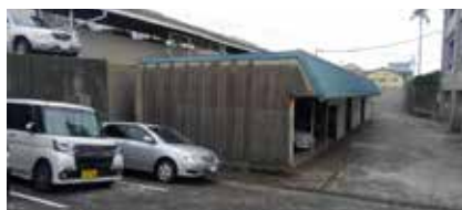
防災センター建設予定地（市役所敷地内）
