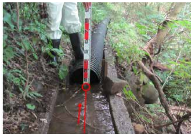
開水路から波型パイプに変更
