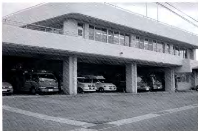
消防ポンプ自動車を更新する消防署
