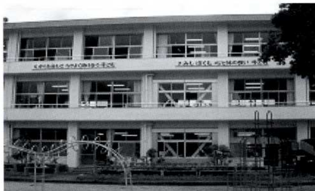
耐震化工事が終了した市来小学校
