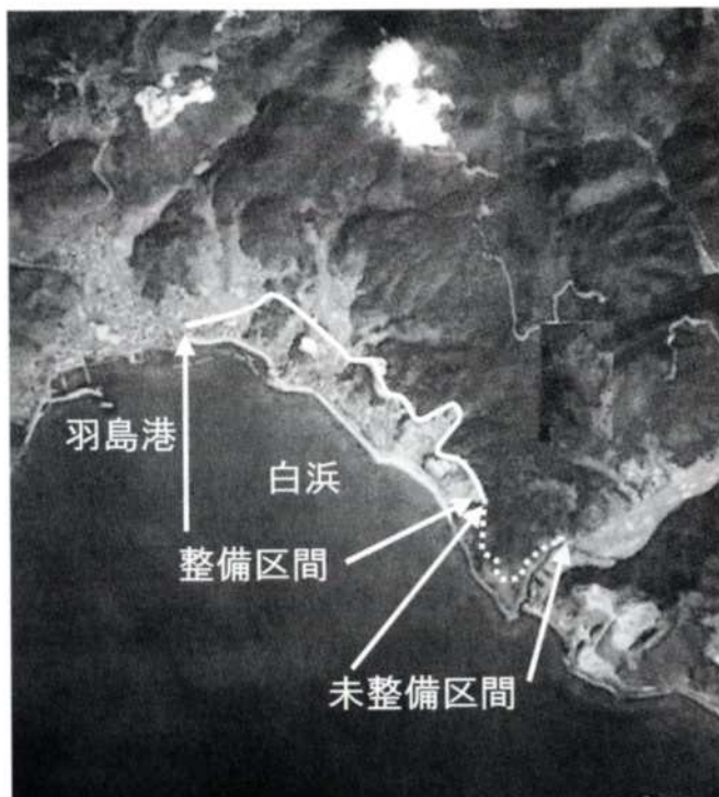
ふるさと農道整備区間・未整備区間
