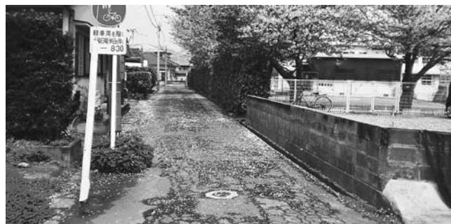
舗装される串小西通線
