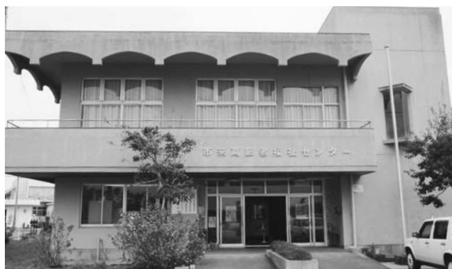
外壁が改修される市来高齢者福祉センター
