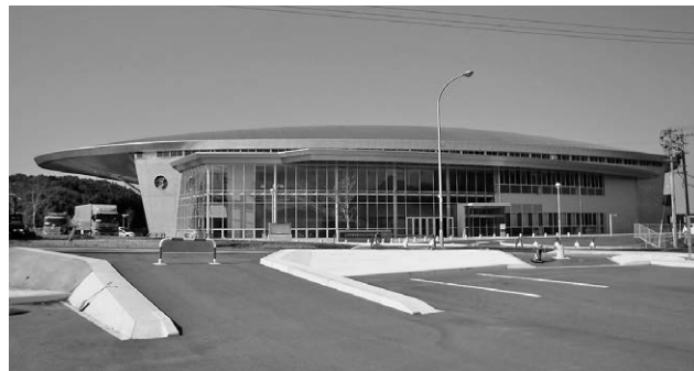
完成した総合体育館
