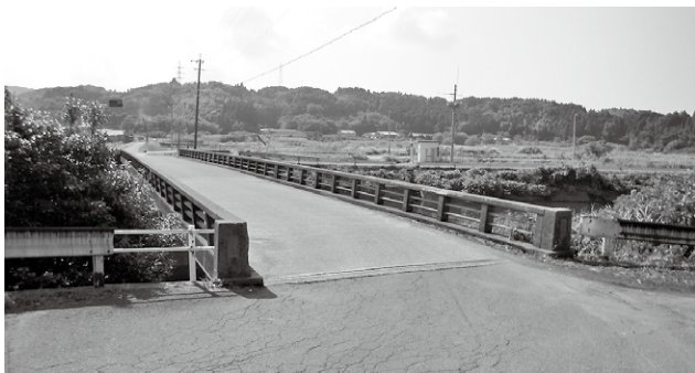
架け替えられる海瀬橋
