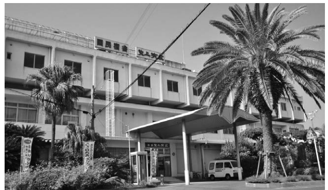
玄関前車寄屋根が改修された吹上浜荘
