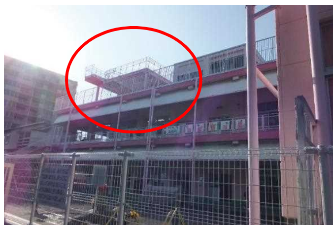
図 15 屋上への避難場所を増築した事例
