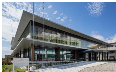
図 4-5-11 神奈川県足柄郡開成町 庁舎における ZEB 事例 出典：松田平田設計 HP
