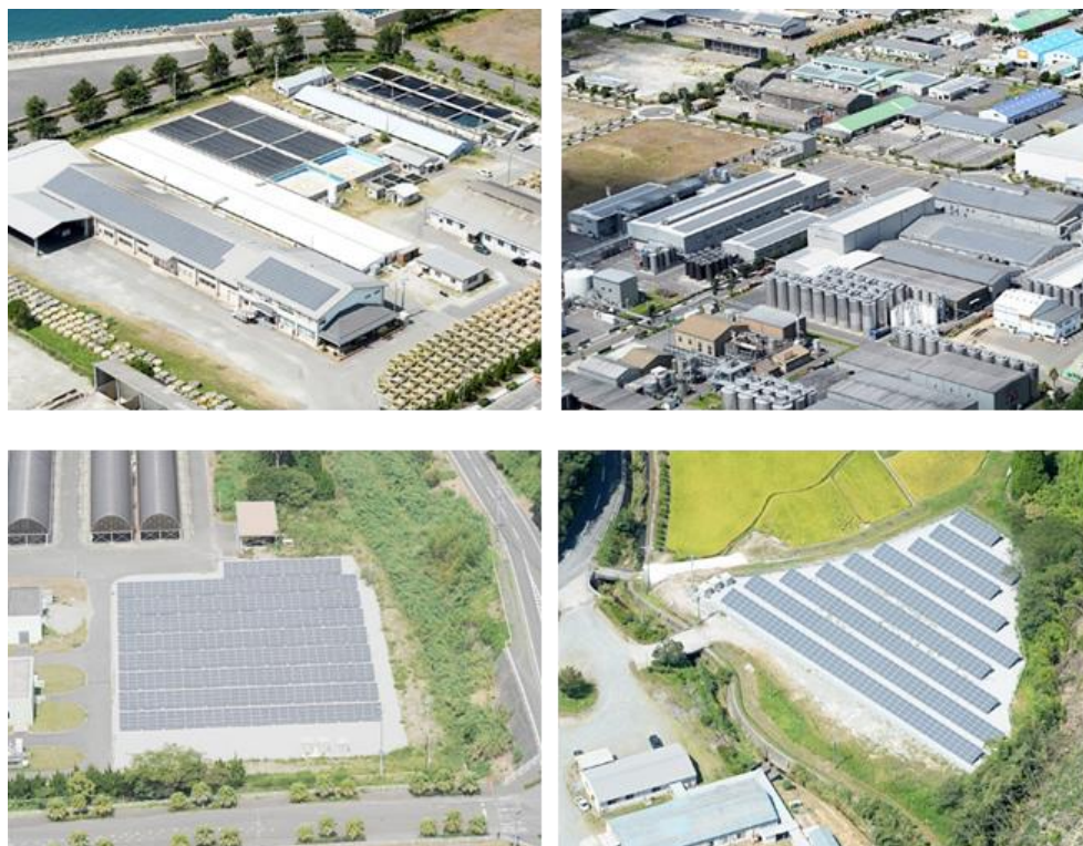
図 3-5-1 西薩中核工業団地における太陽光発電のようす
