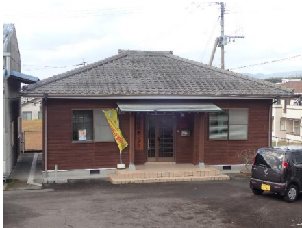
センター管理棟外観
