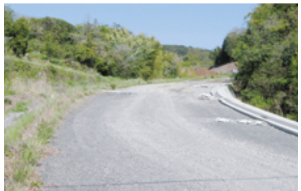
市道松比良線道路改良事業
