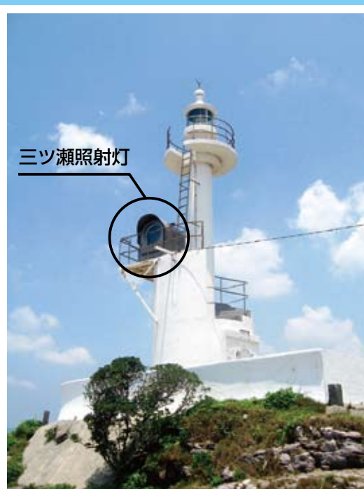
旧串木野港灯台に設置されている三ツ瀬照射灯
