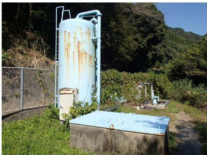
図 5-4-1 老朽化が進行する浄水施設(急速ろ過設備)
