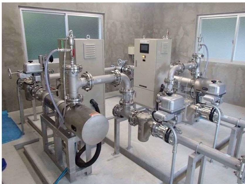
図 3-4-2-6 第 1 水源地(小ヶ倉) 紫外線処理設備
