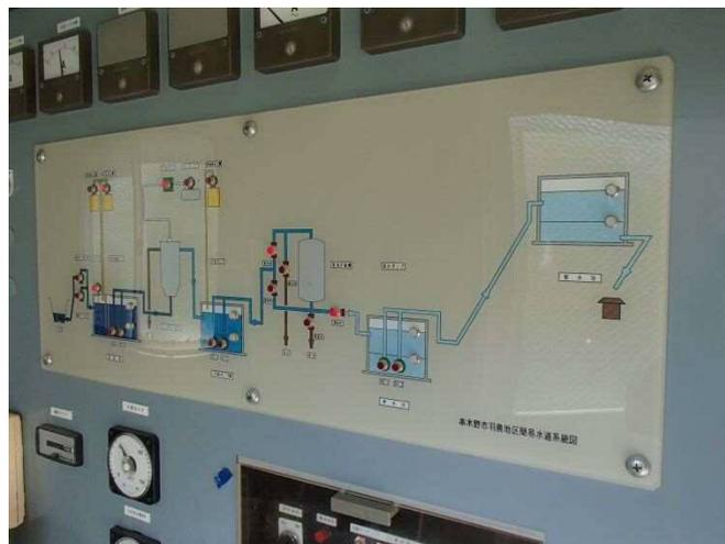
図 3-4-2-8 浄水系統フロー(計装盤)
