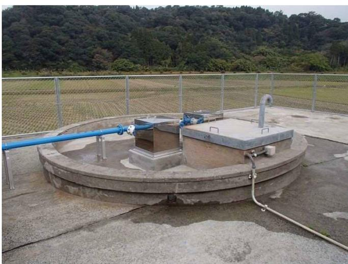
図 2-2-3 浅層地下水の地上部
