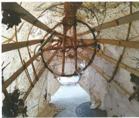
写真 25 ツルの内部の様子
