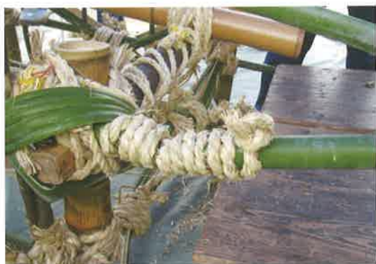
写真8 骨を折り曲げる部分を縄で補強
