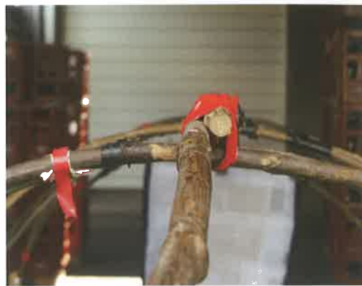
写真2(上) 後曲棒の接続部を針金で固定
