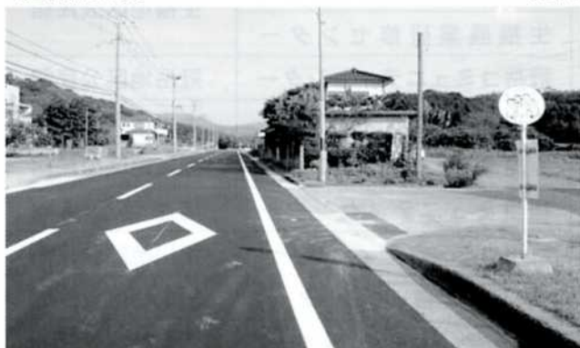
道路舗装工事が終わった市道河内線
