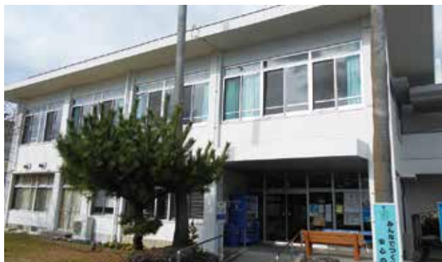
羽島交流センター内に屋内退避施設を整備
