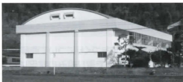
耐震補強された川上小屋内運動場
