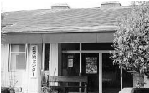
改修される旭交流センター
