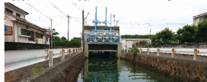
(満潮時の塩田雨水ゲートポンプ場)
