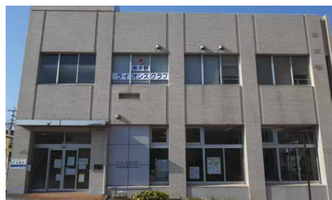
(改修を行う中央交流センター)
