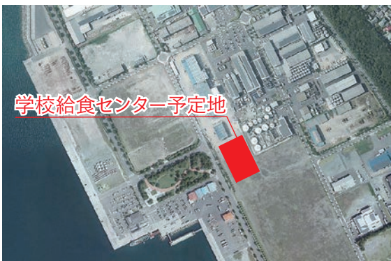
建設予定地（西薩中核工業団地内）
