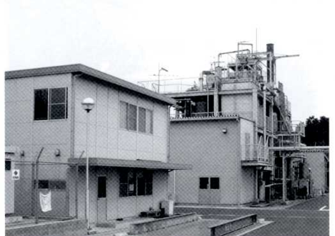
市来一般廃棄物利用エネルギーセンター
