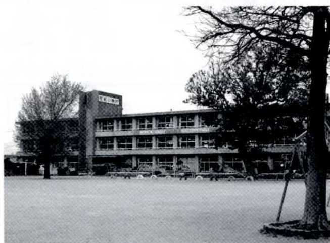
大規模改造工事を行う市来小学校
