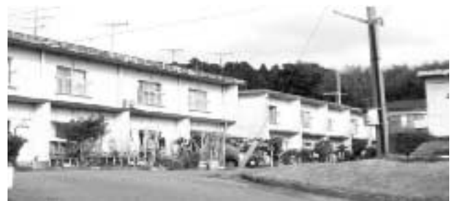
外壁が改修される佐保井住宅
