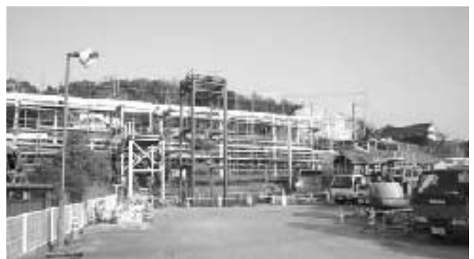
整備が進む神村学園前駅
