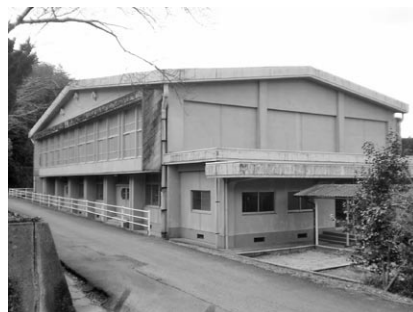
屋根が補修される生福小屋体
