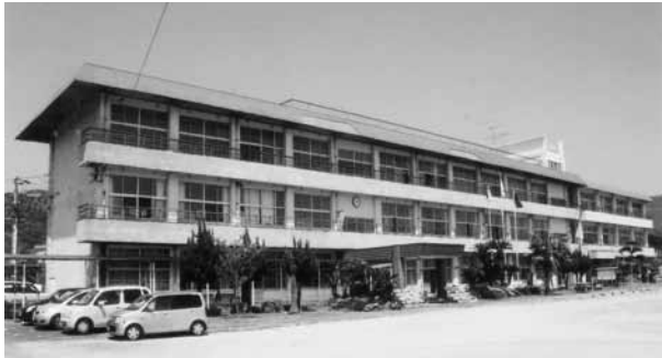
耐震補強工事などが施工される羽島中学校
