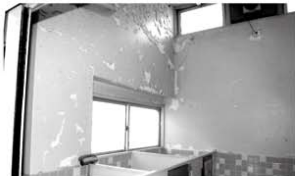
補修される生福保育所のトイレの壁
