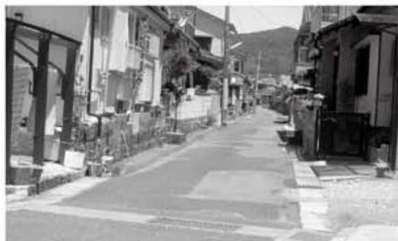
舗装等がされる串木野漁港北側
