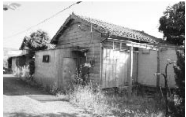
老朽化に伴い解体予定の郷野原住宅の木造家屋
