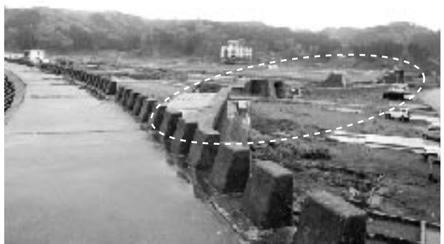
崩壊したスーパー堤防
