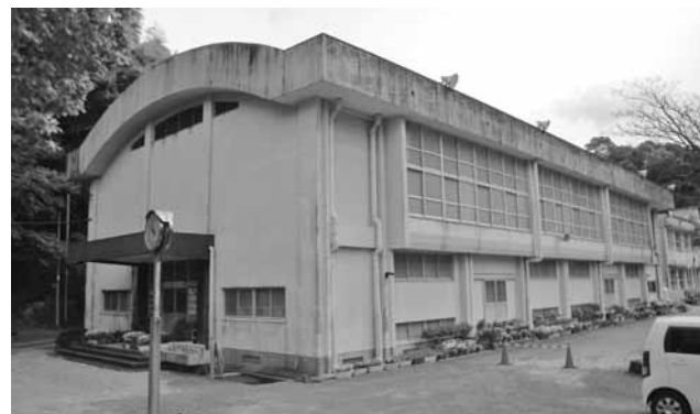
耐震補強される冠岳小屋内運動場
