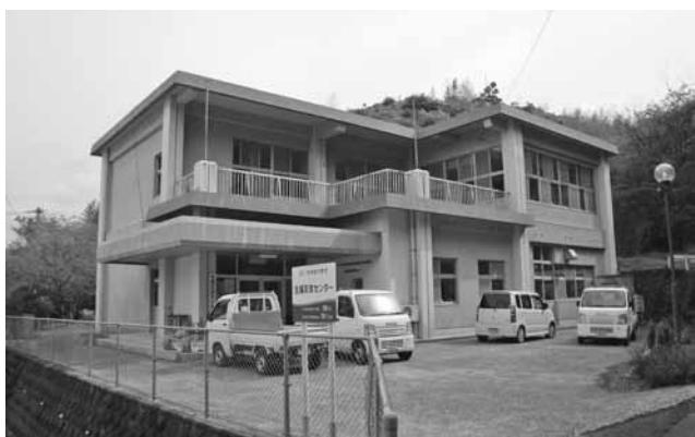
改修される生福交流センター
