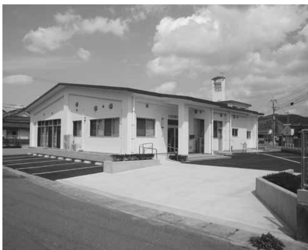
新設された本浦交流センター（3月完成）
