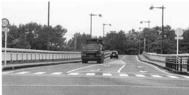
補修される新港大橋
