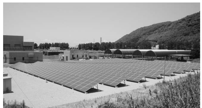
串木野フリーセンターに設置された太陽光発電施設
