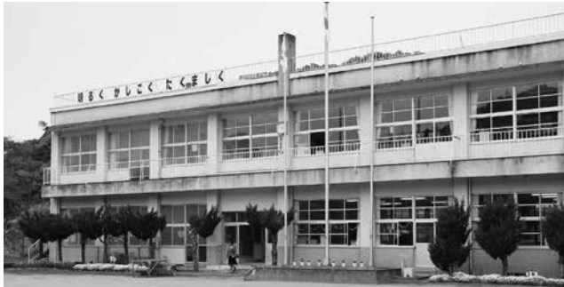
耐震補強される生福小学校
