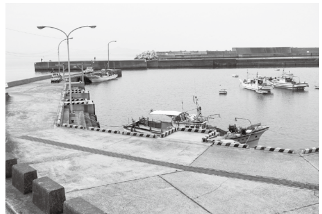
整備予定の戸崎漁港
