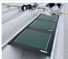
折板屋根への設置例
