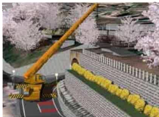
＜公園づくりの工事の状況＞
