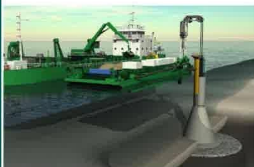
基礎へのバラストの詰め込み
