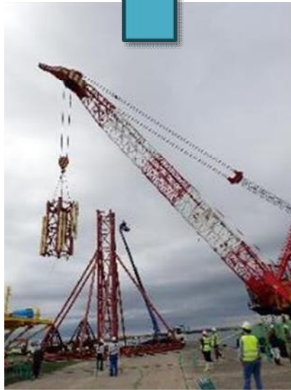
組み上げ作業
