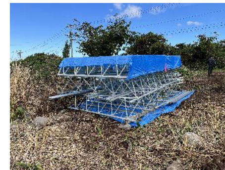
風況観測マスト塔体部分（例、一部）
