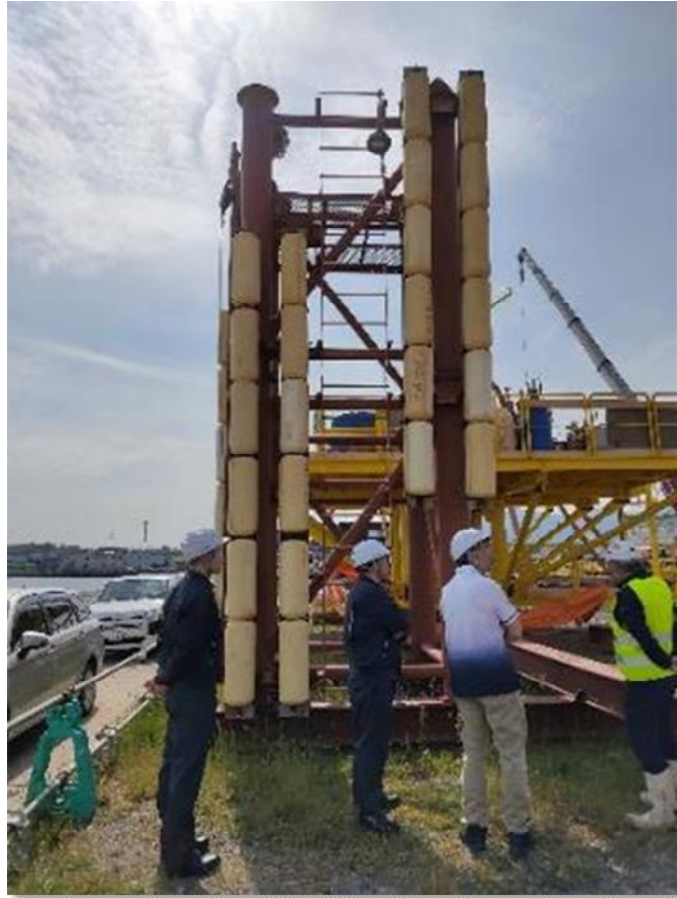
鋼製櫓の部材搬入
