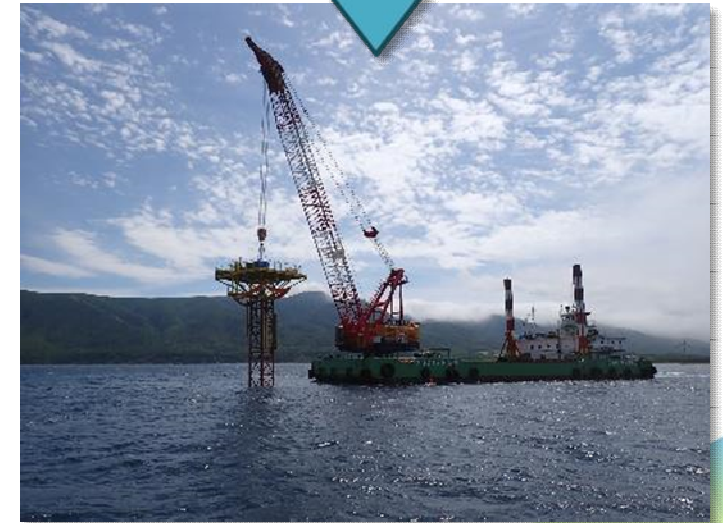
掘削地点への設置
