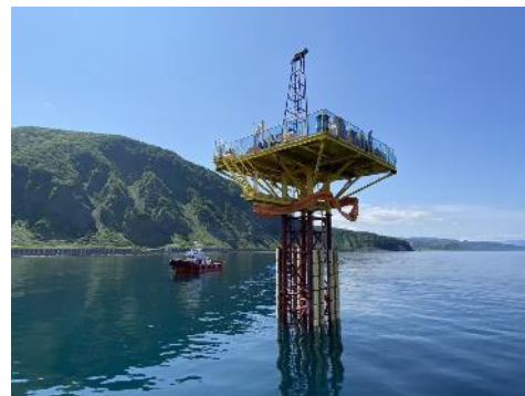
鋼製櫓の設置状況
