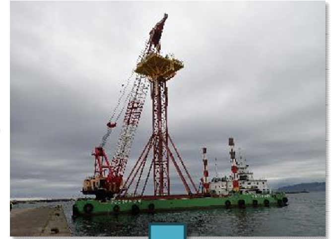
運搬用の起重機船への搭載
