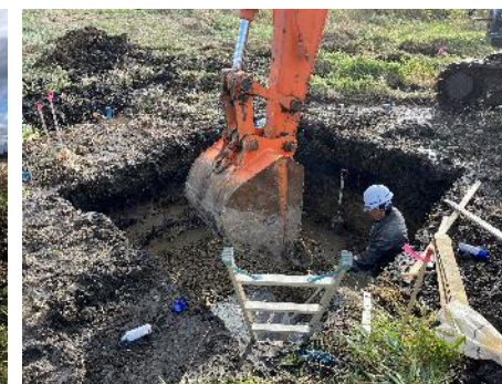
風況観測マスト基礎部分の埋設（例）
