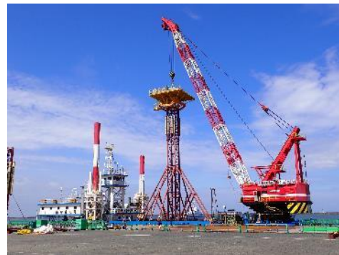
鋼製櫓の輸送
