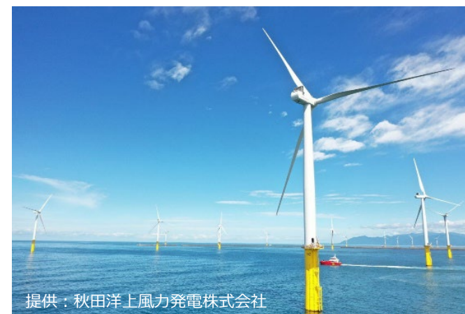
着床式洋上風力（秋田県 能代港内・秋田港内）※写真は能代港
