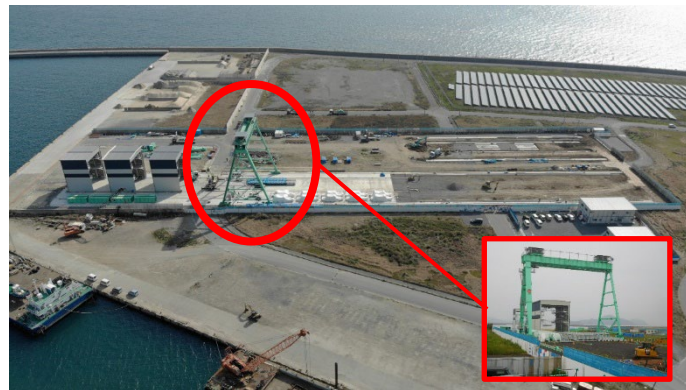
拠点港における洋上風車の建造ヤード
