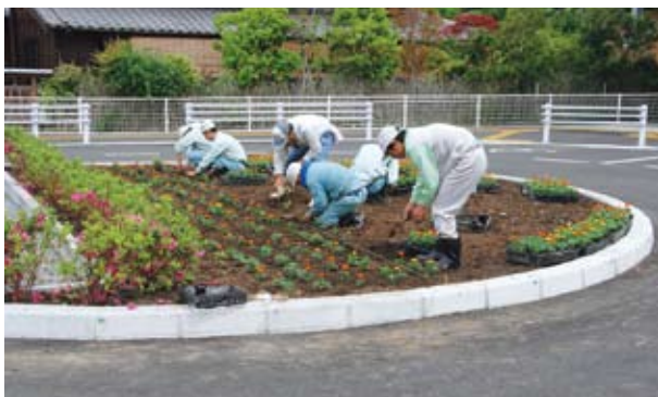
▲串木野養護学校の生徒たちによる植栽風景
