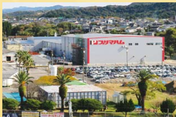
工場増設工事が進むプリマハム(株)鹿児島工場
