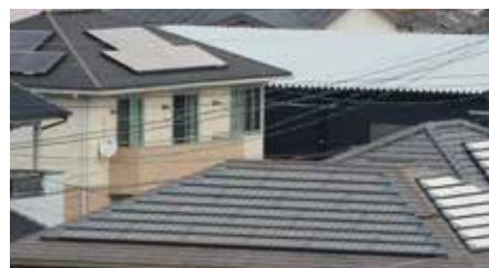
住宅用太陽光発電パネル
