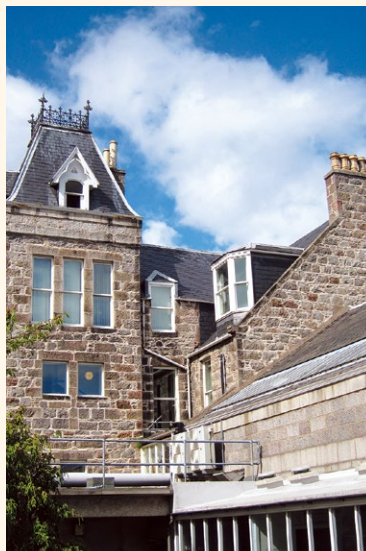
長沢鼎が通った中学校の校舎
