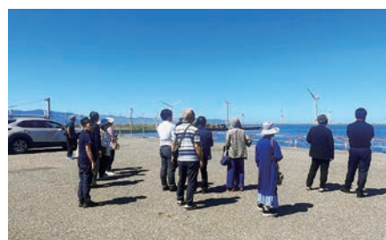
石狩湾新港洋上風力発電所（現地視察）
