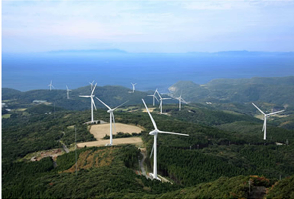
図 3-5-4 串木野れいめい風力発電所のようす
