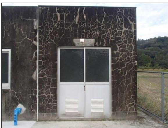
図 3-1-6(左) 構造物の劣化の一例(RC造管理棟)
