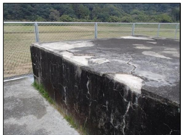
図 3-1-7(右) 構造物の劣化の一例(RC造水槽)
