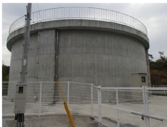
図 3-4-5-7 牛ノ江配水池
