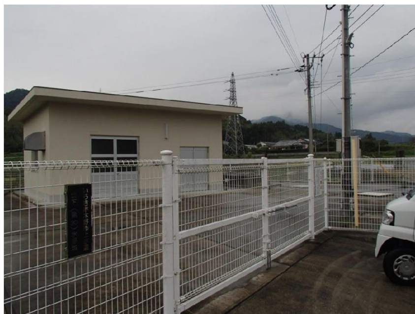
図 3-4-1-6 第 30(坂下)水源地
