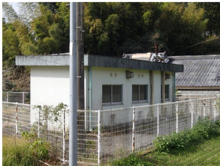
図 3-4-4-6 生冠第2水源地の外観
