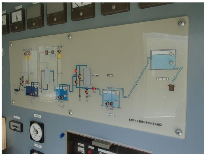
図 3-4-2-8 浄水系統フロー(計装盤)
