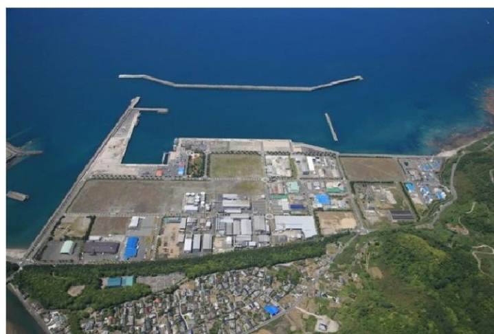
図 3-4-1-2 串木野新港(鹿児島県ホームページより)
