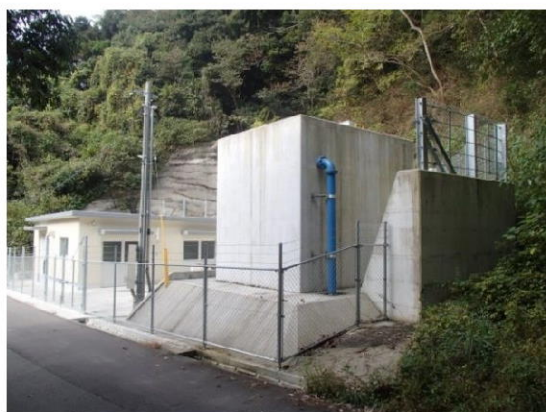
図 3-4-5-6 中ノ平水源地
