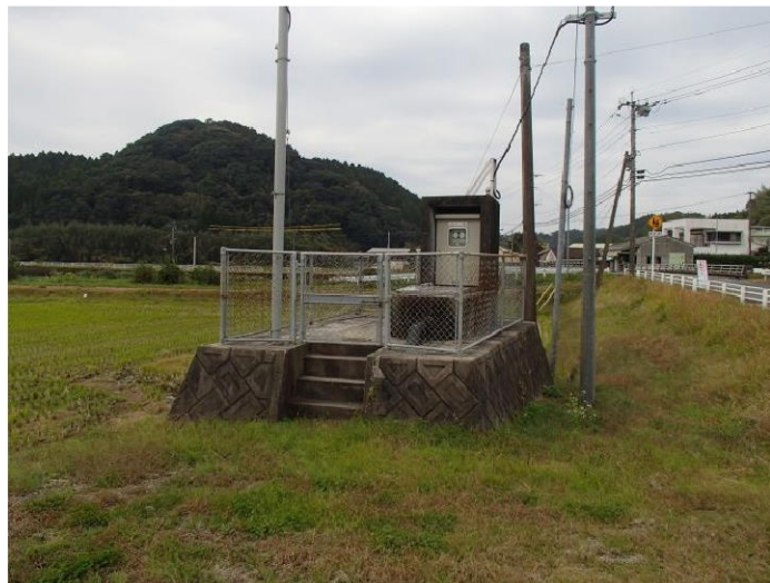
図 3-4-5-5 内門第2水源地
