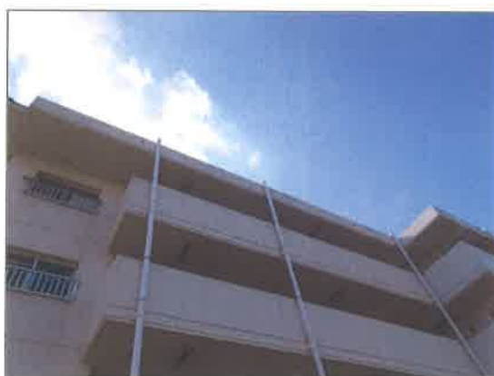
D棟 外壁状況
