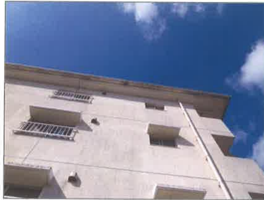
A棟外壁状況
