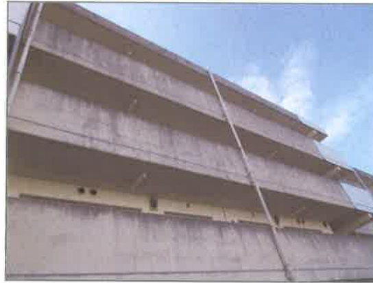
A棟外壁状況
