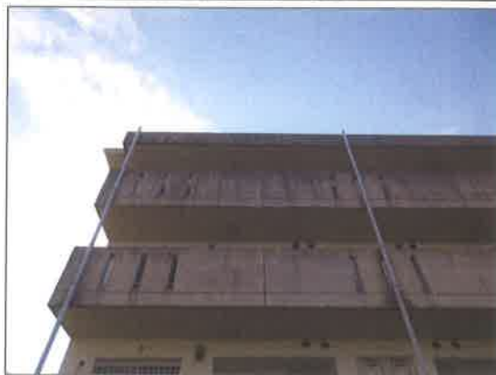
B棟 外壁状況
