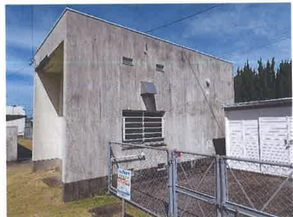
受水槽ポンプ室
