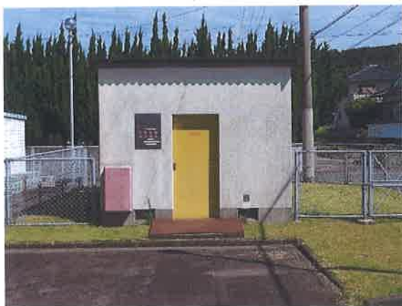
プロパンポンベ庫
